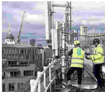
▲ In cantiere Al lavoro
